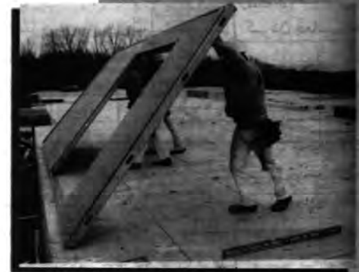
شکل ۱۵. شیوه نصب دیوار پانلی در سیستم LSF
