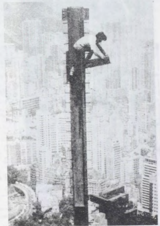
a/b (۹) تصاویر نصب و سرپایی اسکلت غیرعادی برج را در شرایط فوق‌العاده دشوار اجرایی، نشان می‌دهد.
