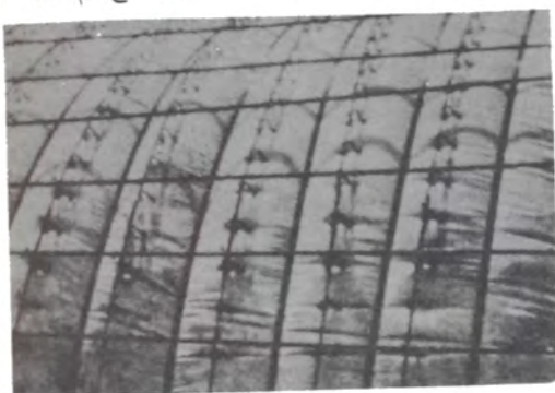
۳۹- نحوه اتصال شبکه های فولادی بدخل و خارج فرم بادی
