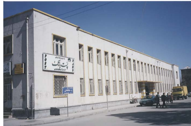
الف. جبهه جنوبی ساختمان پست و تلگراف، سال ۱۳۸۱، عکاس: همتی (آرشیو روابط عمومی پست استان فارس).
