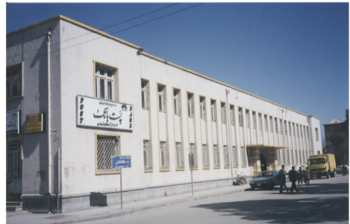
الف. جبهه جنوبی ساختمان پست و تلگراف، سال ۱۳۸۱، عکاس: همتی (آرشیو روابط عمومی پست استان فارس).
