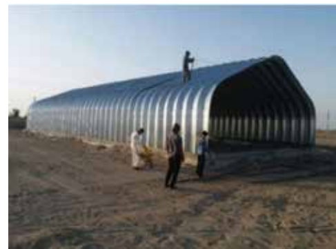
آغاز کارگاه سنگ
