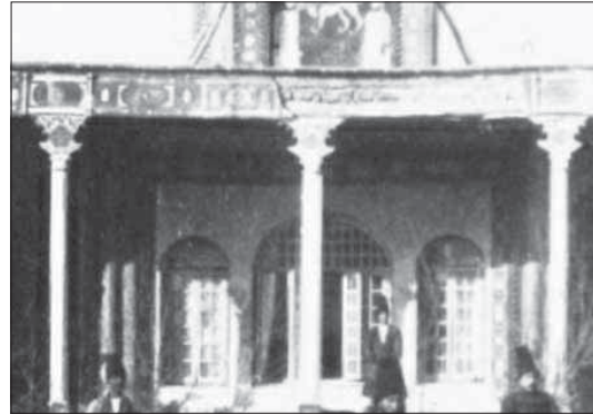
ت ۳۷ (بالا). تصویر شکم‌دادگی تیر میانه جبهه شمالی حیاط مدرسه اقدم، بزرگ‌نمایی «ت ۳۶». مأخذ: آلبوم‌خانه کاخ گلستان، با تصرف. ت ۳۸ (پایین). جبهه شمالی مدرسه اقدم با توجه به «ت ۳۵» پایین: نمای پشت ایوان بالا: نمای ایوان و پشتش، ترسیم: نگارنده.
