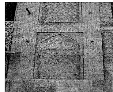
۴- قسمتی از نمای شرقی مسجد جامع
