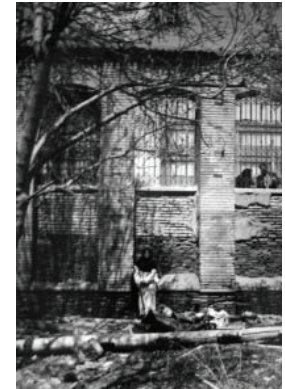
ت ۱۰. فرو رفتن بنا در زمین (خانه نراقی). ت ۱۱. مقطع خانه دوره اول (خانه تواضعی).
