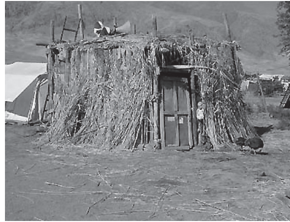
ت ۹. (بالا) استفاده از مصالح بومی جهت ساخت مسکن موقت، (پایین) بهره‌گیری از اسکلت چوبی با پوشش نی با کاربری مسجد، مأخذ: بنیاد مسکن انقلاب اسلامی، همان.
