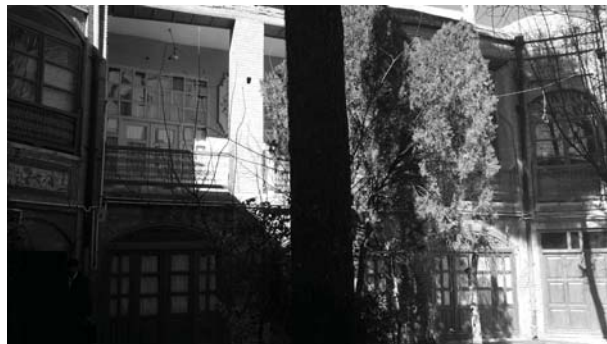
طارمه ضلع غربی (استفاده از سایه‌اندازی)
