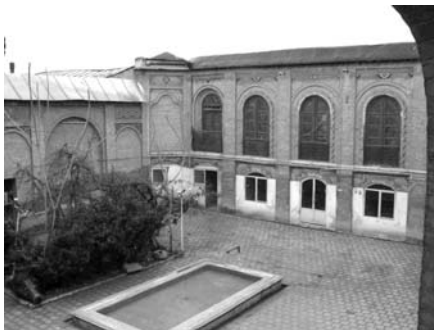
حوضخانه جنوبی و طاق‌نماهای ضلع غربی
