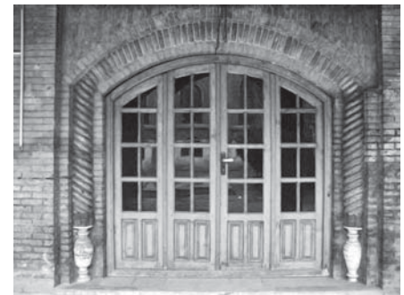
ورودی اتاق در ضلع غربی
