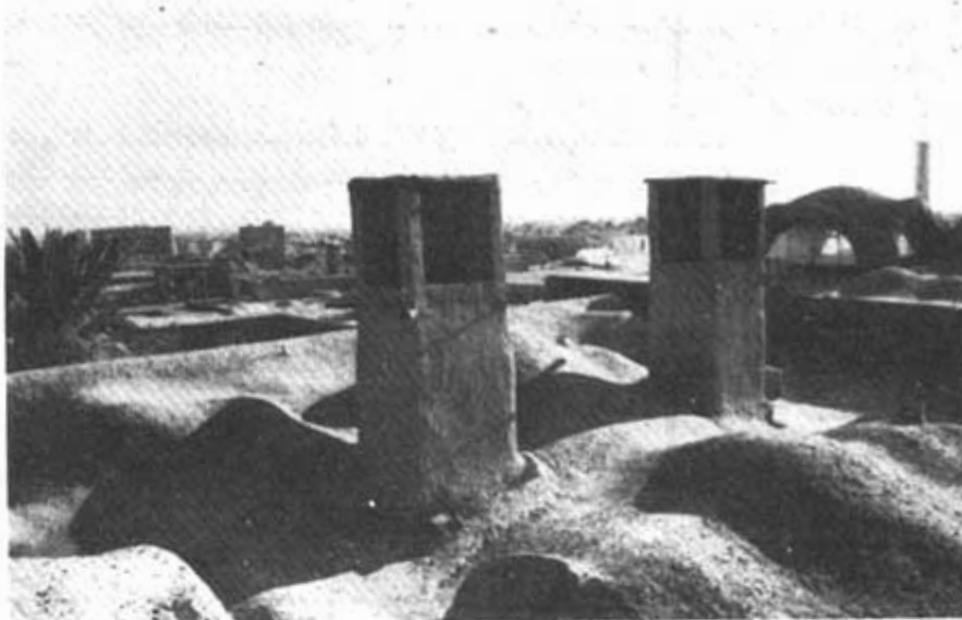
تصویر ۱۰- چهار صفت و بادگیرهای بکار رفته در معماری خانه‌های زواره
