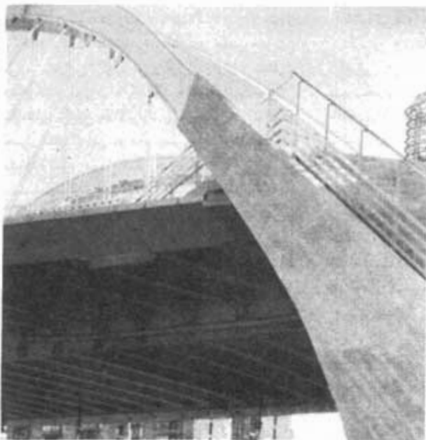
«ایستگاه قطار «استادلهوفن» (Stadelhofen) روریخ سال (۹۰-۱۹۸۳) - میلادی ستون‌های جنگالی از جنس فولاد، کف بتنی قسمت گردشگاه را حمل می‌کند.
