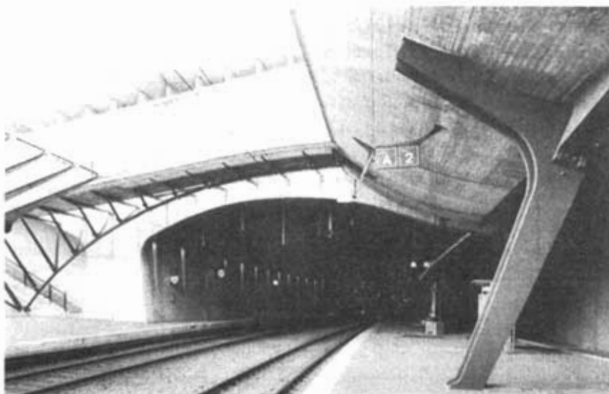
«ایستگاه قطار «استادلهوفن» (Stadelhofen) روریخ سال (۹۰-۱۹۸۳) - میلادی ستون‌های جنگالی از جنس فولاد، کف بتنی قسمت گردشگاه را حمل می‌کند.
