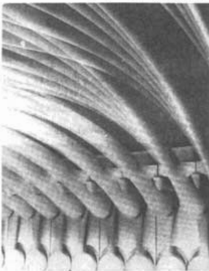
غرفه ساختمانی سوئیس (Swissbau Pavilion) شهر بازل (Basel) سوئیس سال ۱۹۸۹ میلادی
