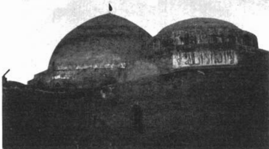
- گنبد مسجدکبود بعد از مرمت -
