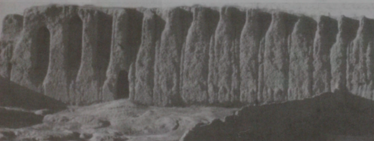
نمونه ای از دیوارهای چینه ای که در سراسر فلات ایران به کار گرفته می شود
